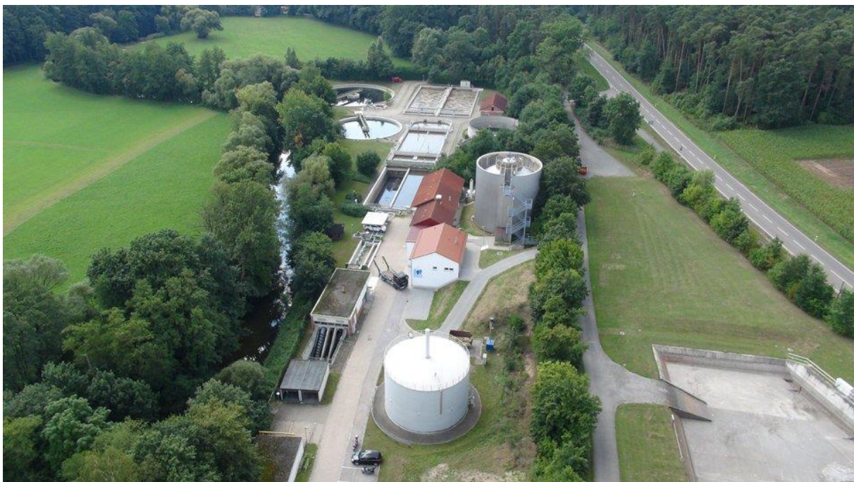
Ansicht auf die Kläranlage aus Osten
