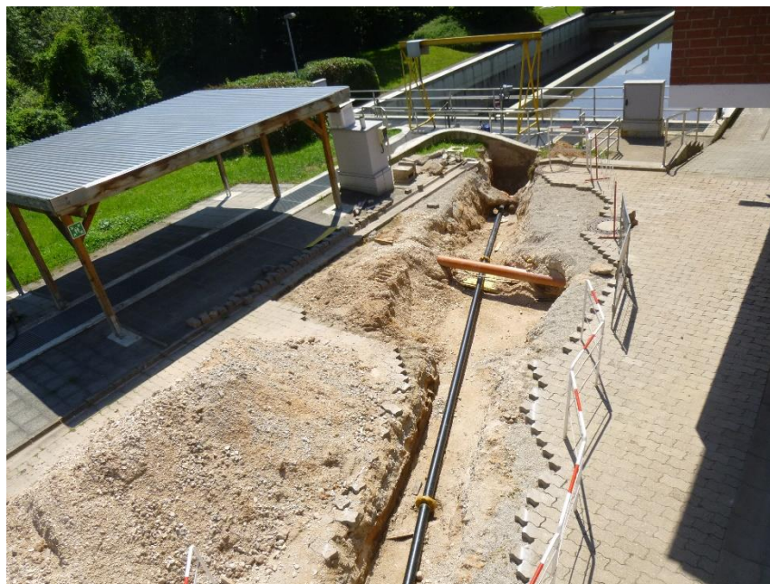
Baugrube mit der neuen Edelstahlleitung
