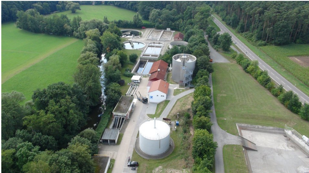
Ansicht auf die Kläranlage aus Osten
